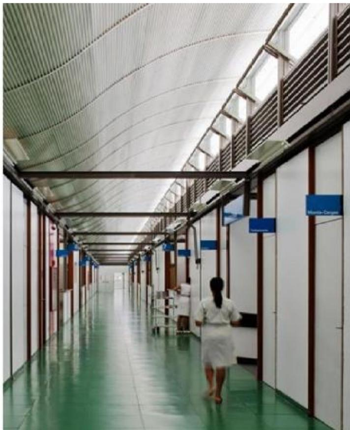
Figura 21 - Hospital do aparelho Locomotor: iluminação e ventilação natural por meio de sheds e estrutura da cobertura em módulos.
