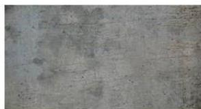
O **Concreto aparente** é uma ótima alternativa econômica na edificação, pois não necessita de reboco e demais revestimentos para cobrir sua superfície, além disso, oportuniza menos manutenções no decorrer dos anos.
