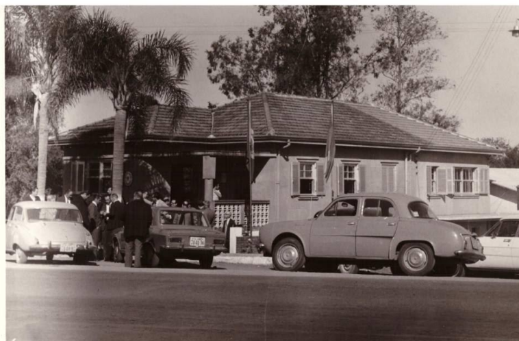
Figura 13 - Prédio da Subprefeitura do distrito de Cachoeirinha 1969
