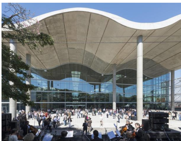
Figura 55 - Cobertura em Concreto
