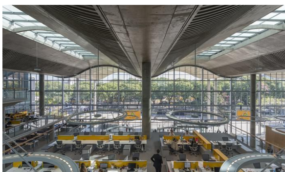
Figura 60 – Estrutura de Concreto
