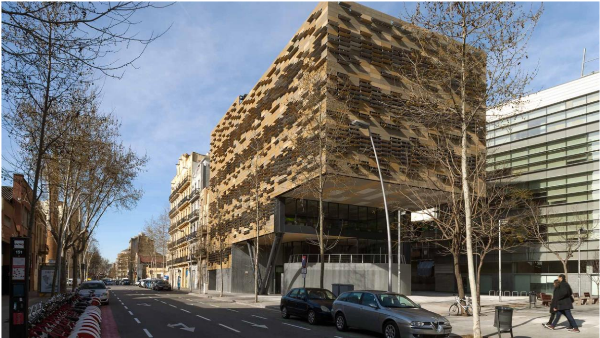
Figura 42 – Fachada principal do CT Leitat
