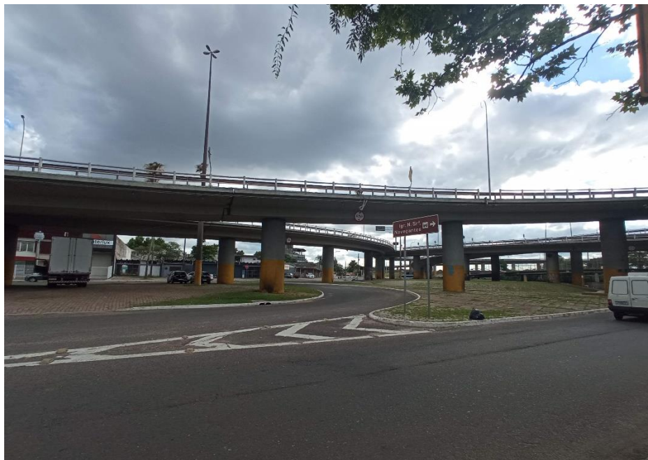
Figura 21 – Viaduto da Ponte do Guaíba
