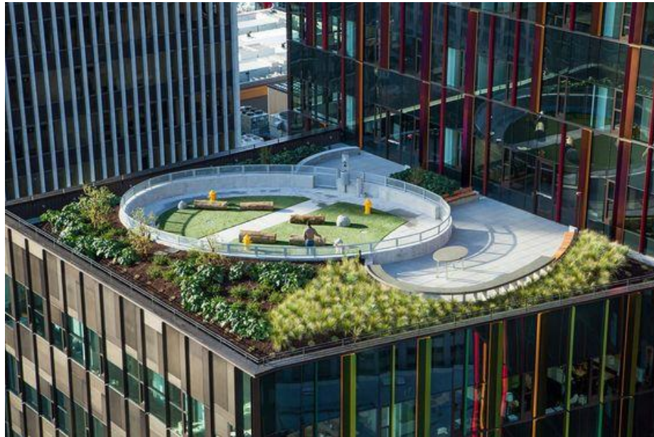
Figura 69 – Cobertura verde com áreas de convivência – CT Monterrey
