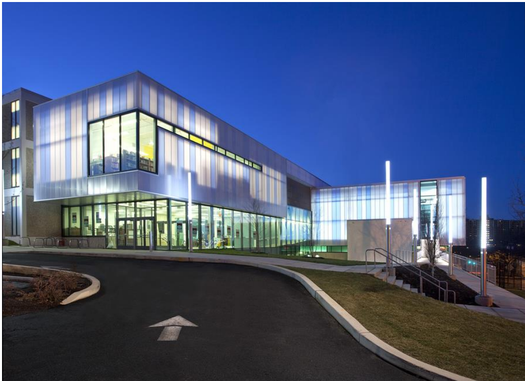
Figura 66 – Fachada com parede translúcida sistema CPI Quadwall
