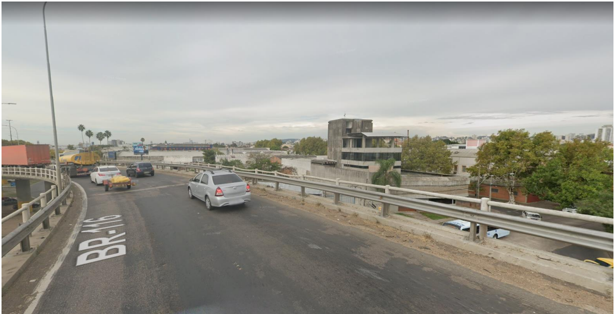
Figura 22 – Vista da ponte do Guaíba
