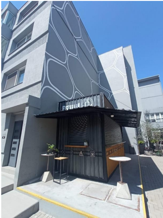
Figura 34 – Fachada lateral Fábrica do Futuro
