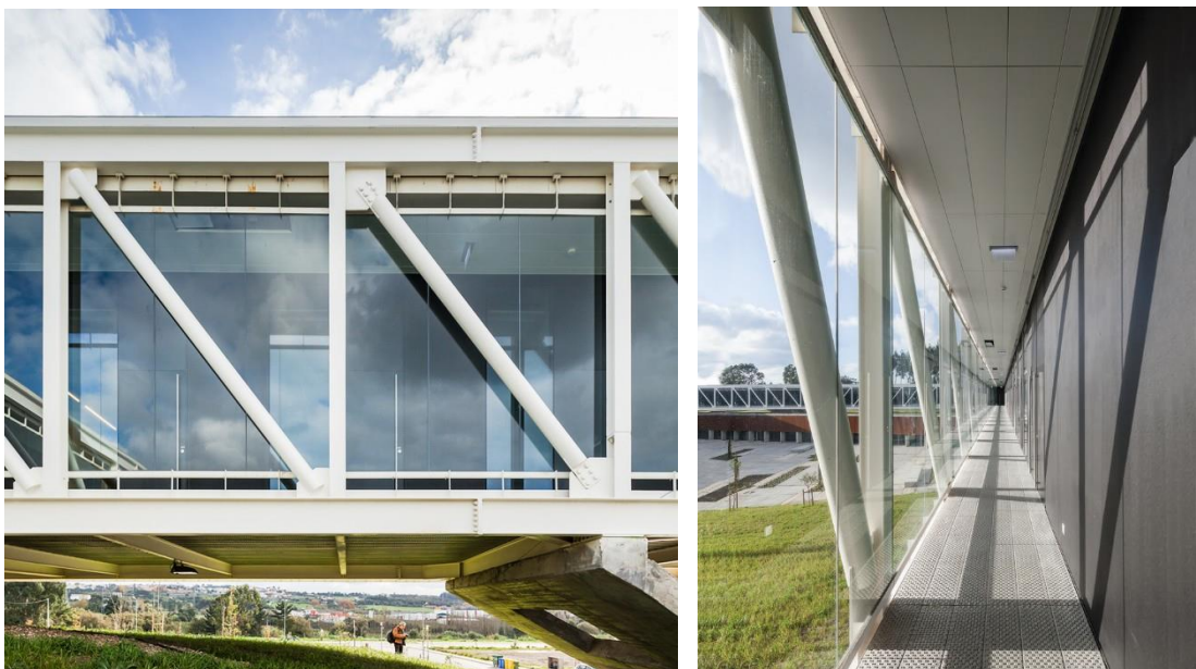
Figura 68 – Estrutura metálica – treliças – CT Monterrey
