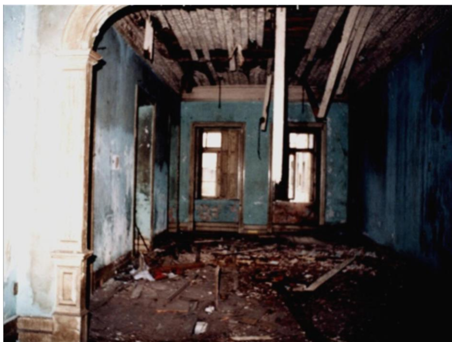
Figura 54: Área interna antes da restauração. Fonte: cedida por Arquiteta Camila Warpechowski
