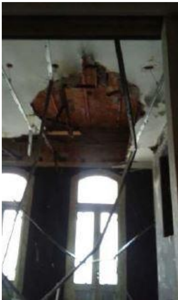
Figura 35: Imagem interna. Fonte: Vistoria da EPACH 2014
