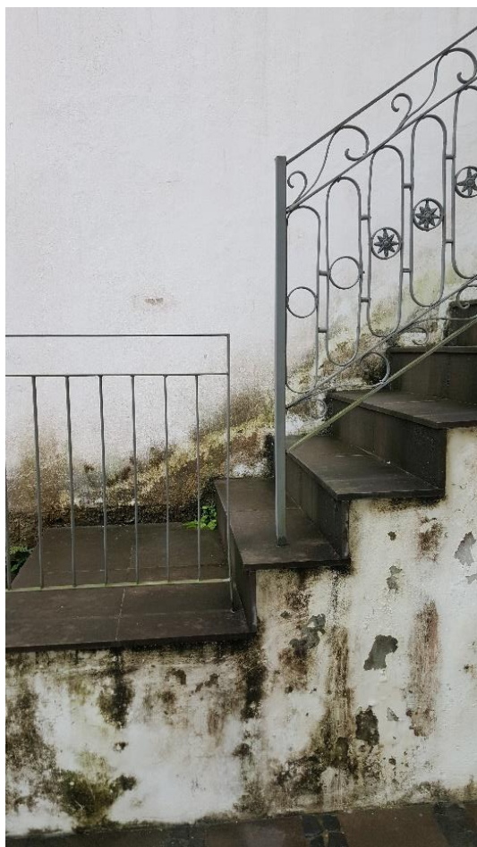
Figura 69: Restauração do guarda-corpo, à esquerda o novo e à direita original. Figura 70: Anexo à casa, após restauração, piso novo, mantendo padrões da época. Fonte: autora. Nov/2018.
