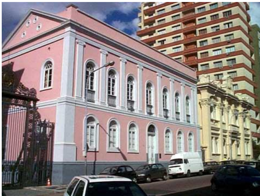
Figura 79: Fachada após restauração.
