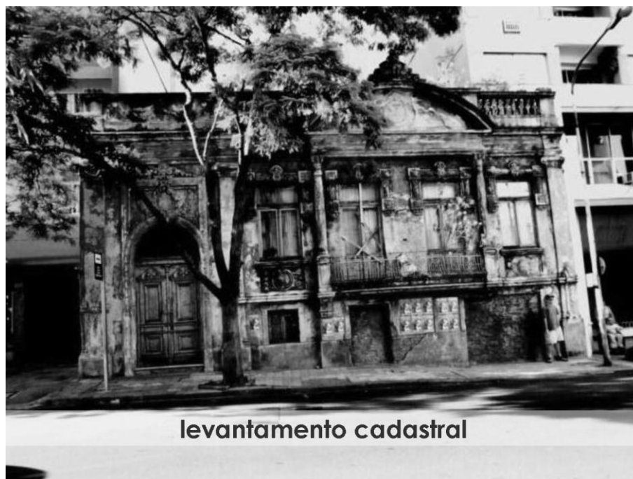
Figura 47: Fachada antes da restauração. Fonte: cedida por Arquiteta Camila Warpechowski
