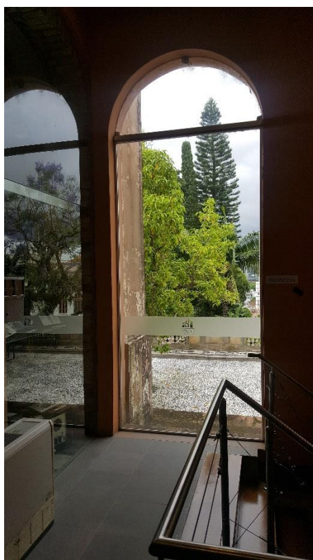
Foto 23: Detalhe aberturas em vidro. Fonte: autora. Out/2018.
