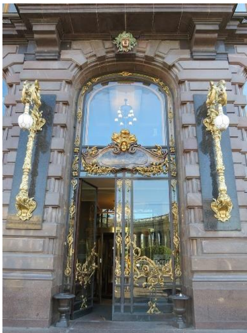
Figura 114: Detalhes entrada principal – Casa Singer. Fonte: cedido por Ben Bender.
