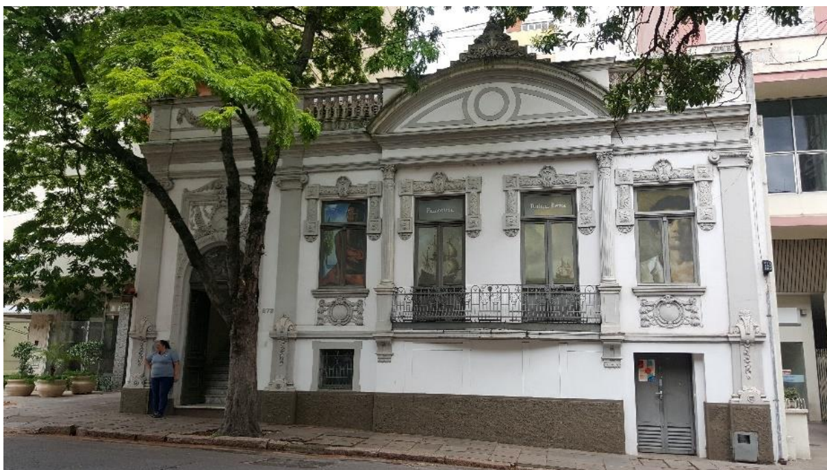
Foto 20: Vista fachada após restauração.
