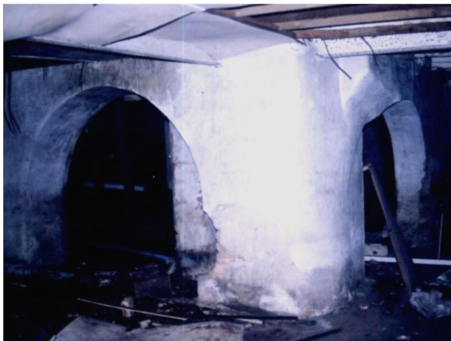
Figura 53: Porão antes da restauração. Fonte: cedida por Arquiteta Camila Warpechowski
