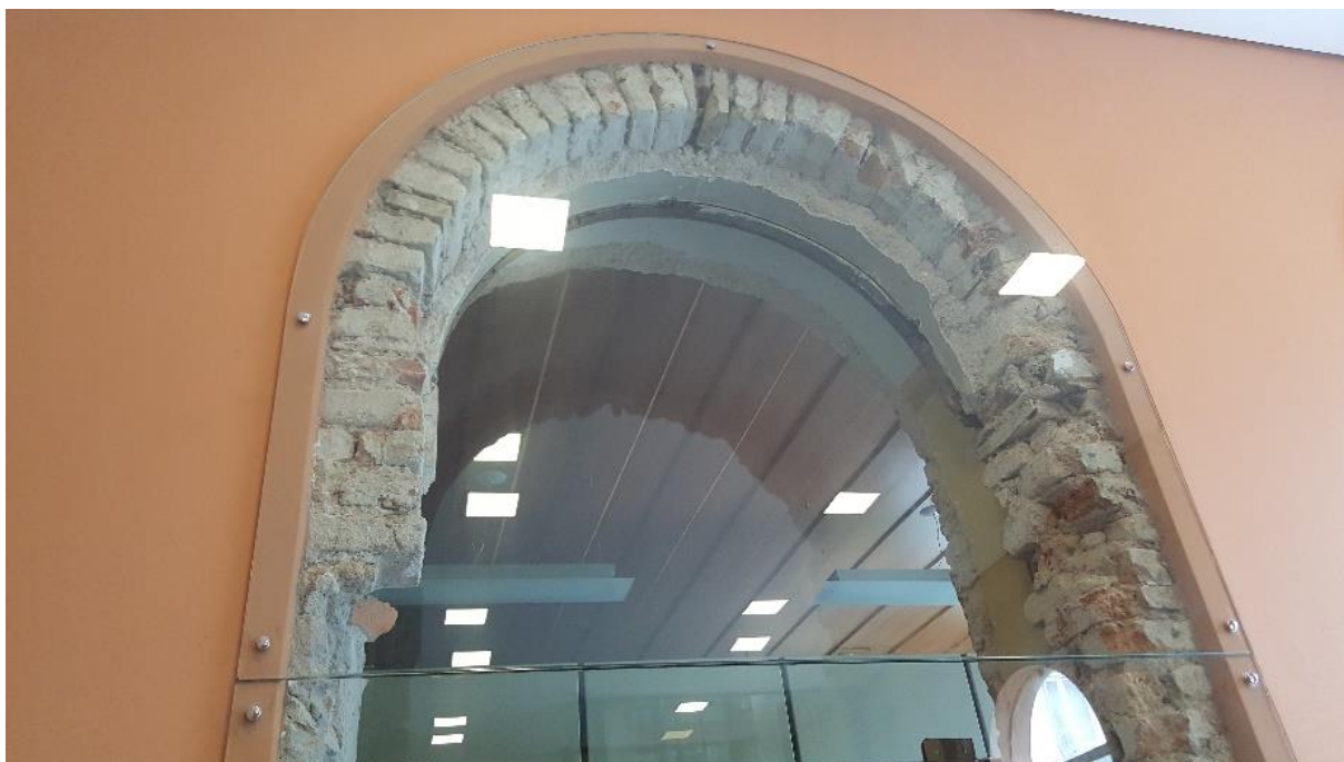
Foto 21: Vista da abertura original protegida por vidro após restauração.
