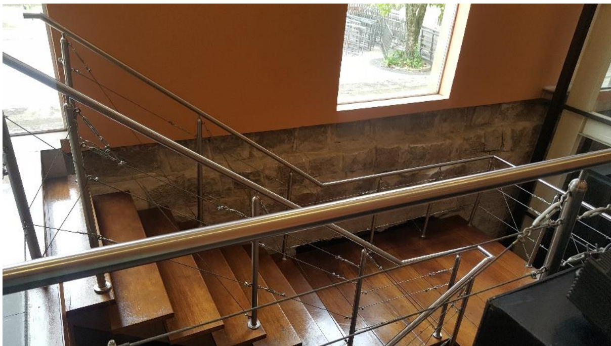
Foto 22: Detalhe revestimento da parede. Fonte: autora. Out/2018.
