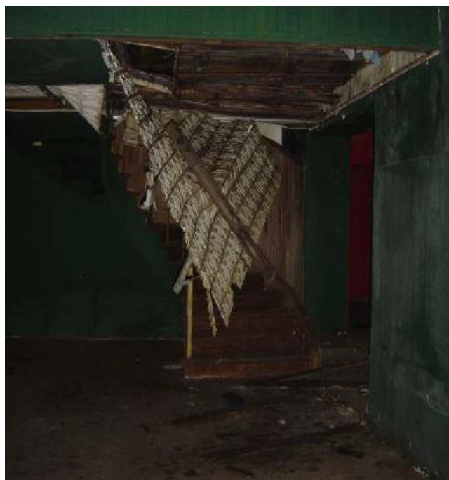
Figura 34: Imagem interna. Fonte: vistoria da EPACH 2014
