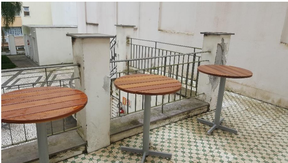
Figura 71: Vista externa com mobiliário da cafeteria. Fonte: autora. Nov/2018.
