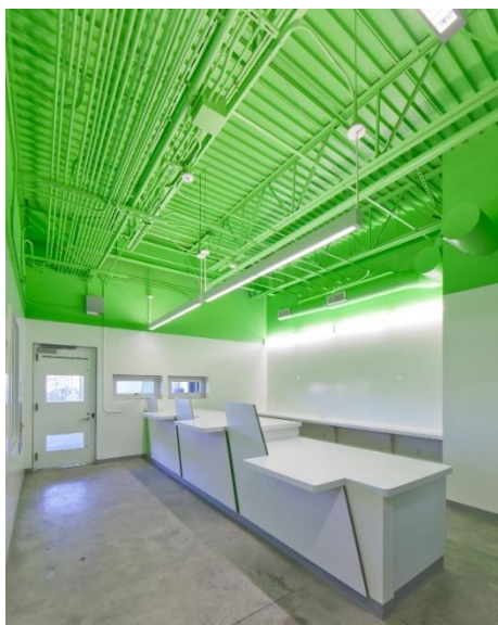
Figura 42 - Estrutura e cobertura metálicas
