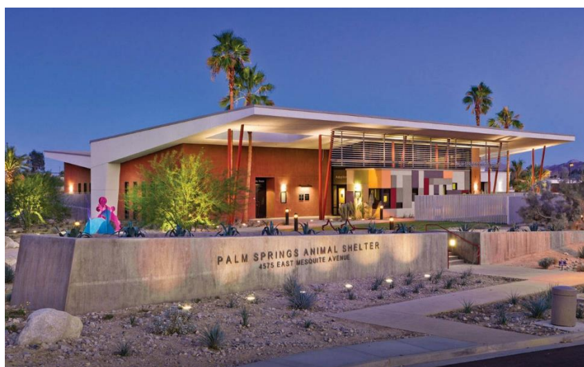
Figura 48 - Contrastes na fachada principal
