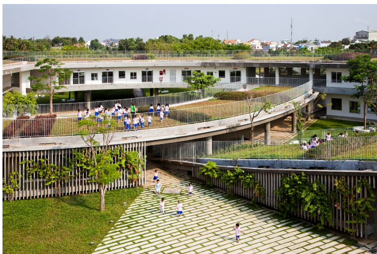
Figura 79 - Brises e ventilação cruzada
