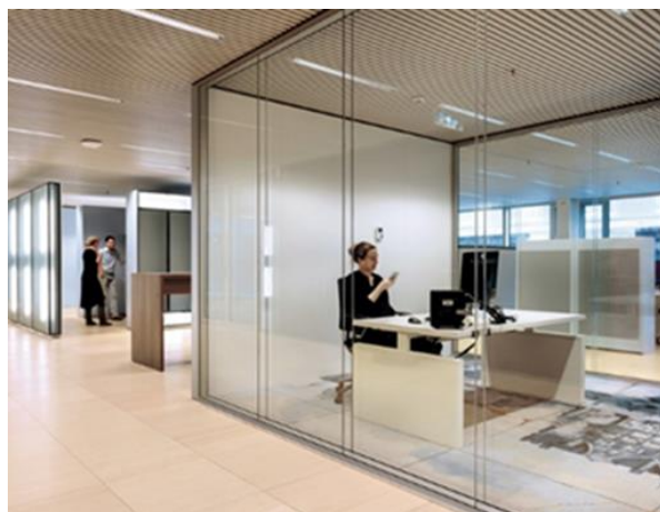
Figura 47 – Divisórias em vidro e aço escovado
