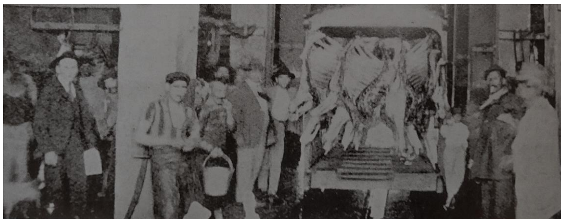
Figura 29 - Antigo Matadouro Pedras Brancas (imagem interna)
