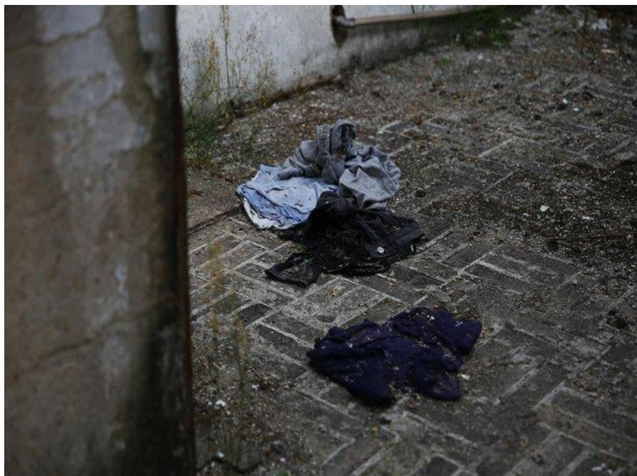
Figura 26 - Pisos faltando e vestígios de pessoas utilizando o espaço.
