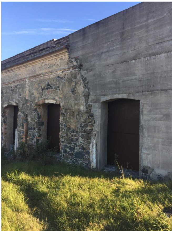
Figura 67 - Parede original em pedra e fechamento da abertura em aço corten
